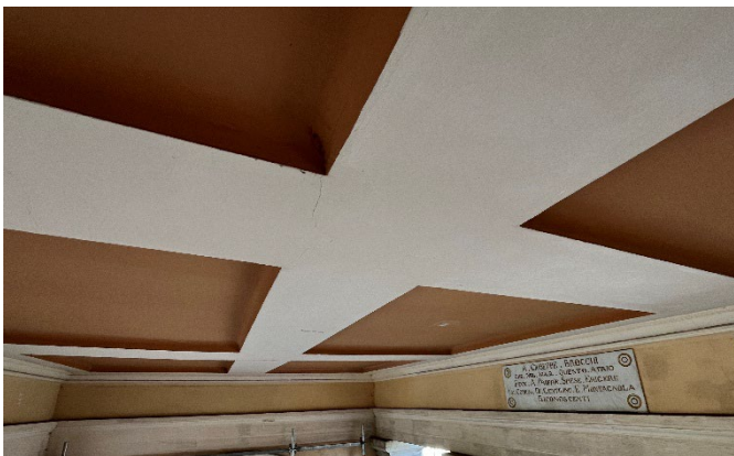
Fig. 5: Soffitto a cassettoni e cornici
