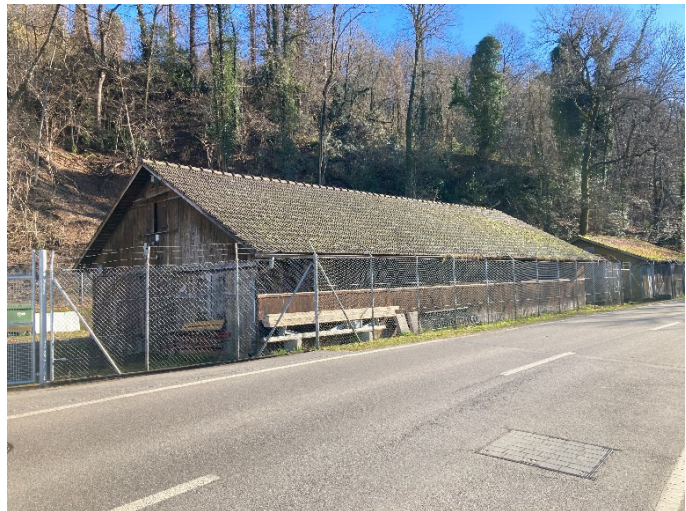
Fig. 2: edificio primario /edificio secondario
