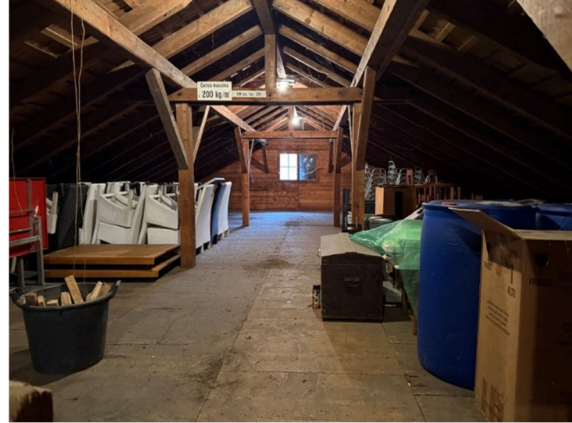
Fig. 5: 1P edificio principale
